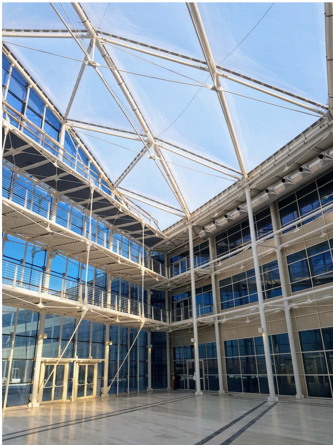
Figura 3.5.1 COPERTURE IN ETFE
